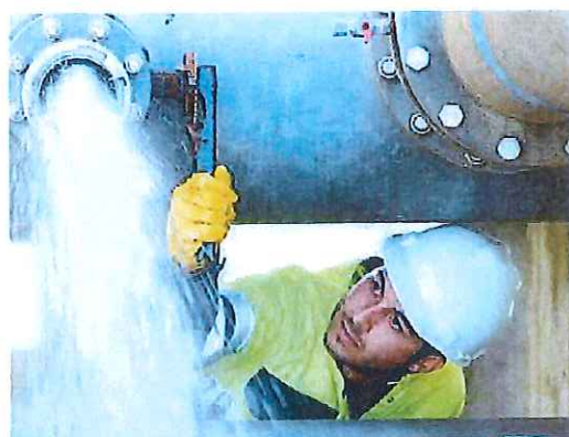
Un operaio di AcegasApsAmga al lavoro
